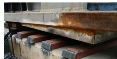
Platine d'appui biaisée →
